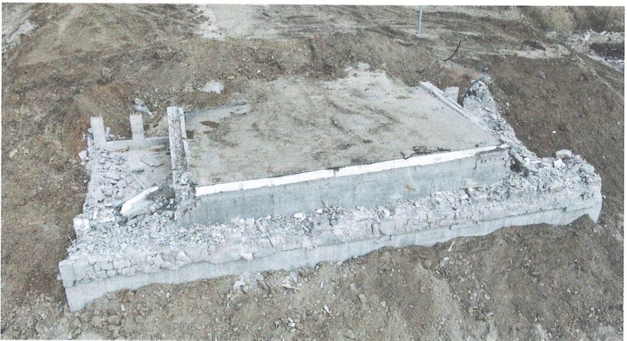
Рисунок 3.1 - Вид опори 0 на час виконання обстеження
