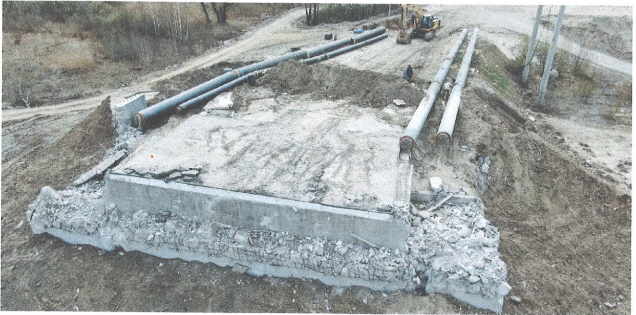
Рисунок 3.2 – Вид опори 1 на час виконання обстеження
